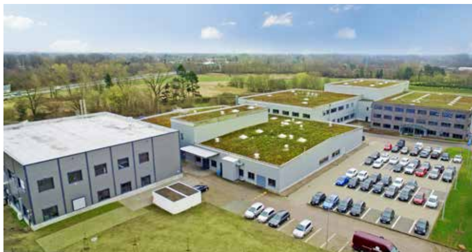
Das 1867 als Lederfabrik G. Metzger & Sohn gegründete Unternehmen ist zwischen 2002 und 2007 aus der Innenstadt in das Gewerbegebiet Gehrstücken umgesiedelt und kommt dort langsam an seine Kapazitätsgrenzen.
