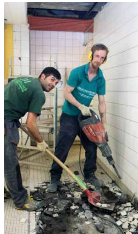
Gerrit Götzen (hinten) und Pastim Paraziti von JM Rückbaubetriebe Trittau hämmern und schaufeln die alten Fliesen weg.
